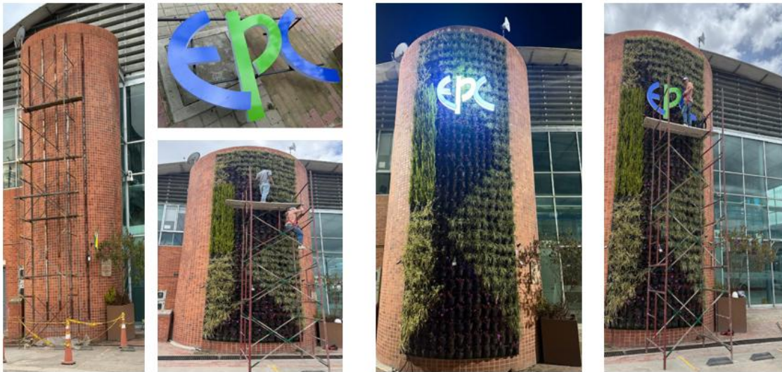
Registro fotográfico de la fachada de EPC fuente propia
