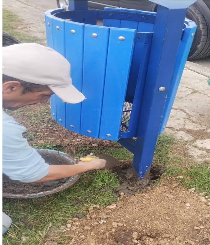
Actividad de rehabilitación y mantenimiento de cestas públicas
