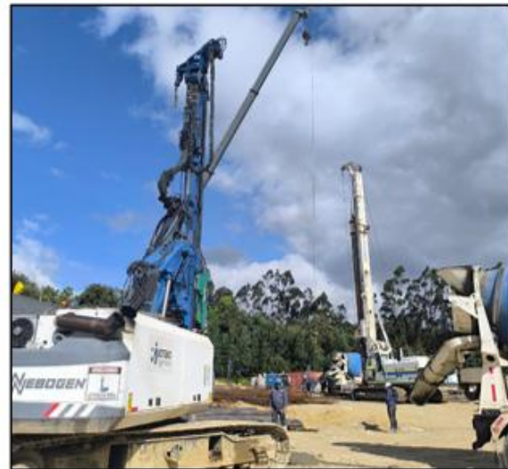
PILOTAJE DE COLUMNAS VIBRADAS 4.673 unidades
