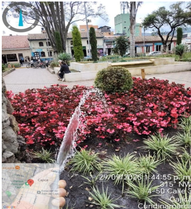
Actividad de rehabilitación y mantenimiento del Parque Principal
