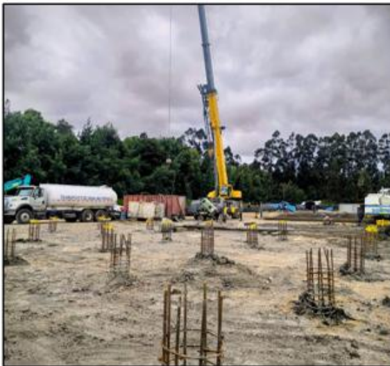
PILOTAJE ESTRUCTURAL 522 unidades
