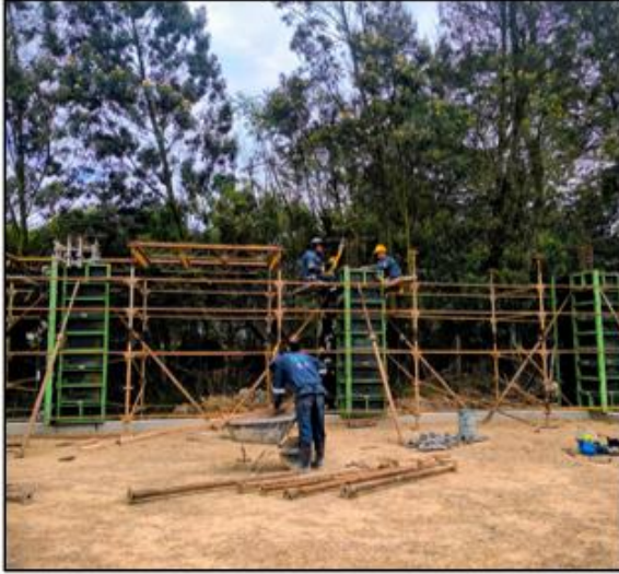
CAMPAMENTO DE OBRA 25% de avance
