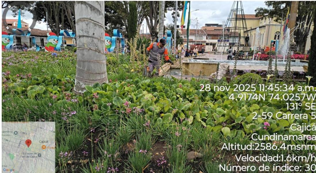
Actividad de rehabilitación y mantenimiento del Parque Principal
