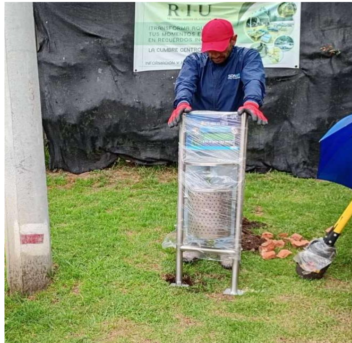
Actividad de instalación de 60 cestas para heces de mascotas
