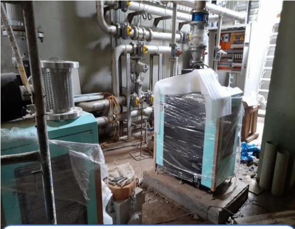
Instalación de Equipos Electromecánicos
