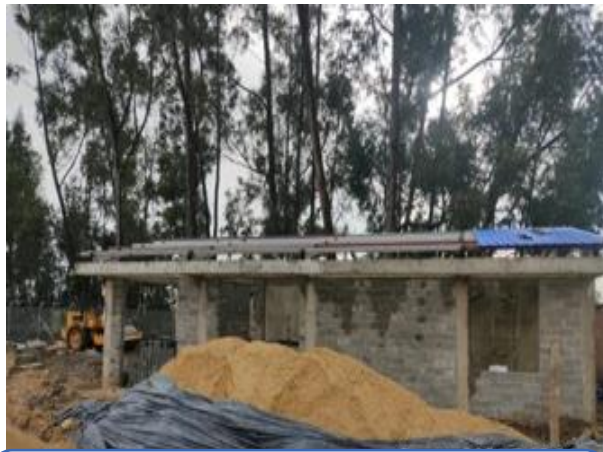
Construcción de Edificio Administrativo
