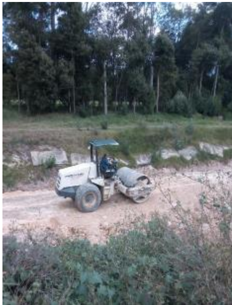
Colocación de C-320
