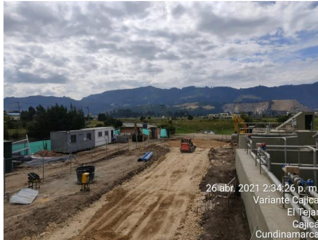
Instalación de B-200
