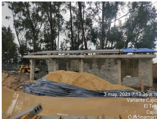
Instalación de cubierta edificio administrativo
