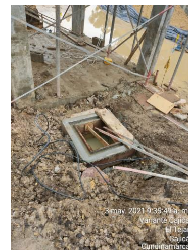
Construcción cajas eléctricas
