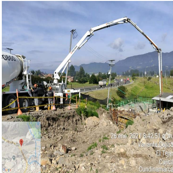
Fundida de muros Estación de Bombeo
