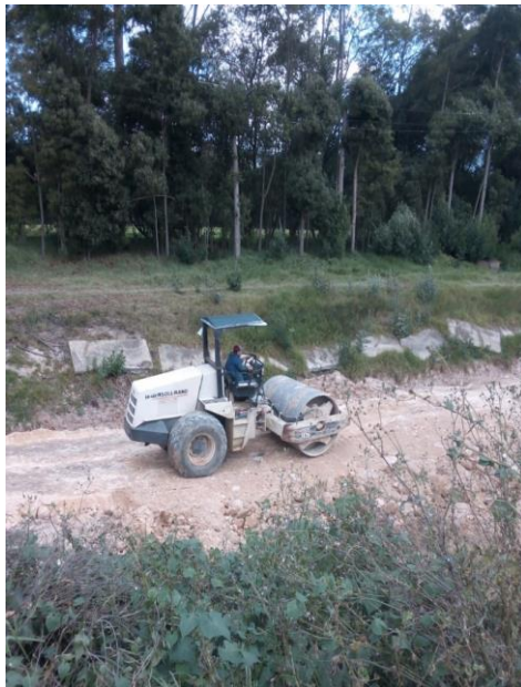
Colocación de C-320
