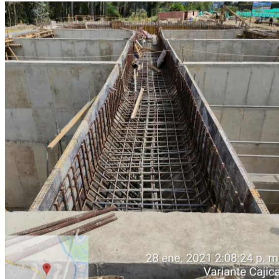
Viga central del Biorreactor
