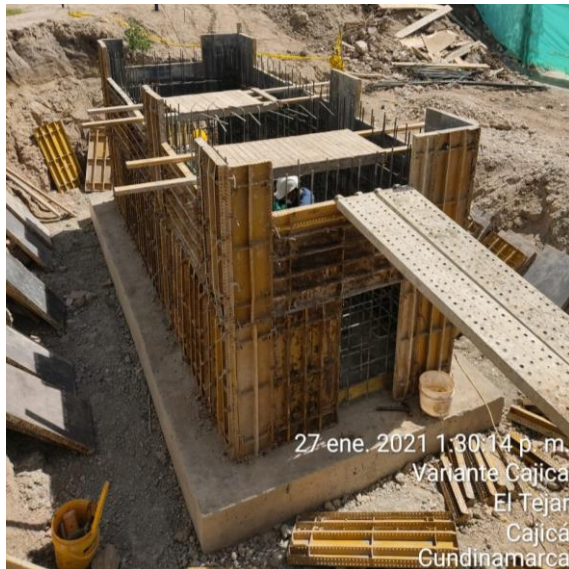
Encofrado medidor de caudales
