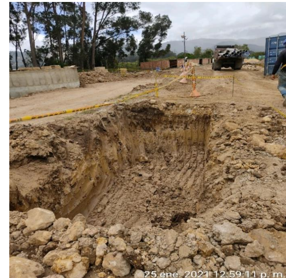
Excavación para la sub estación eléctrica
