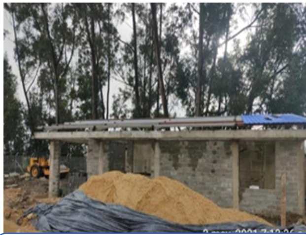
Construcción de Edificio Administrativo
