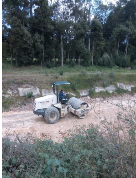
Colocación de C-320
