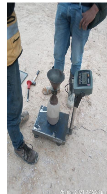
Toma de ensayo de densidades
