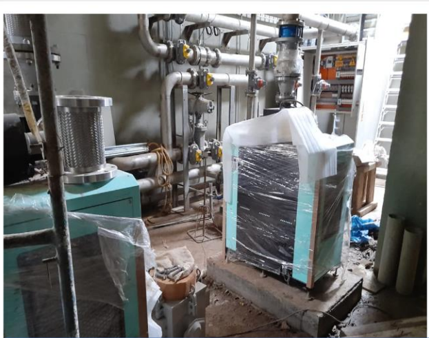
Instalación de Equipos Electromecánicos
