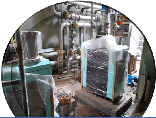
Instalación de Equipos Electromecánicos
