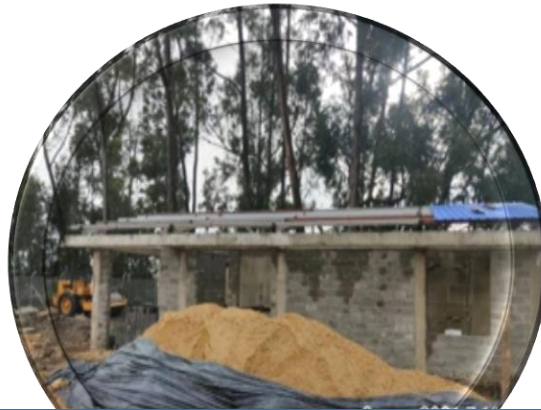
Construcción de Edificio Administrativo
