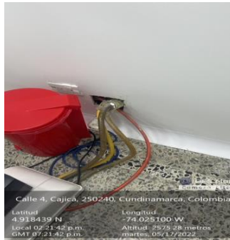
ALMACENAMIENTO TEMPORAL Y DISPOSICIÓN DE RESIDUO PELIGROSOS
