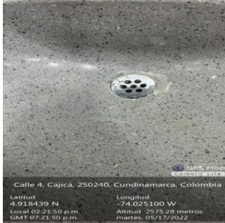
REJILLAS DE LAVAMANOS, POSETAS Y BAÑOS
