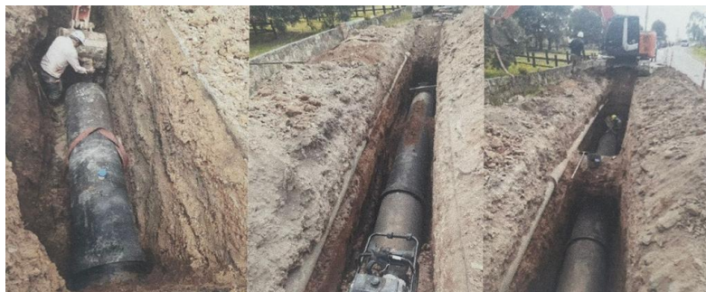
Ilustración 11. Instalacion tuberia 28” en HD.
