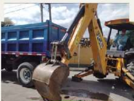
Reconstrucción y Construcción acometidas domiciliarias de agua residuales en el municipio
