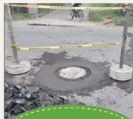
Reconstrucción y Construcción de pozos en el municipio
