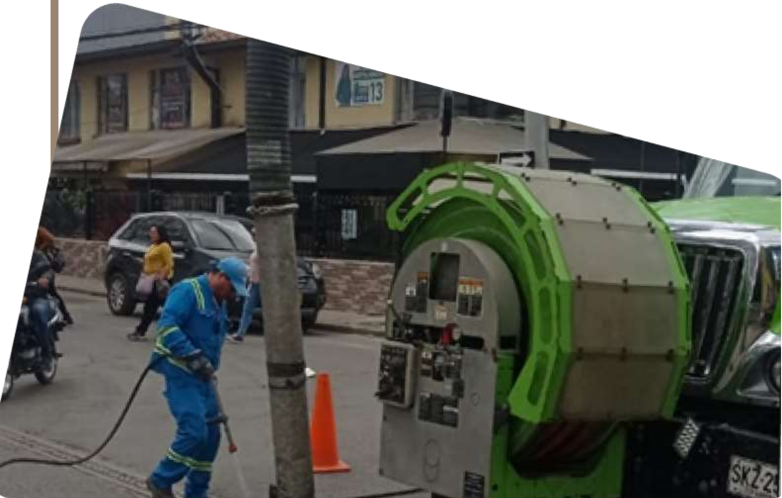
Mantenimiento redes pluviales del municipio
