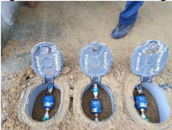
Figura 4. Pavimentación posterior instalación de acometida
