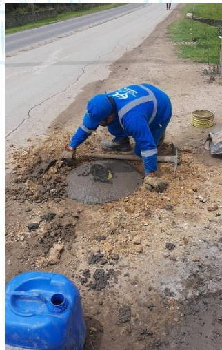
Figura 1. Mantenimiento de válvula agua potable.
