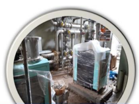
Instalación de Equipos Electromecánicos
