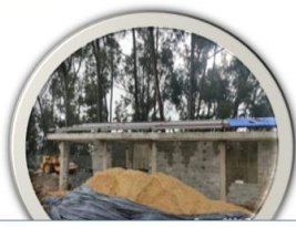
Construcción de Edificio Administrativo
