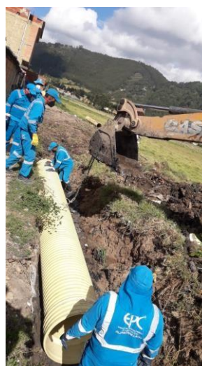
Mantenimiento Sifón Sector Centro – La Bajada
