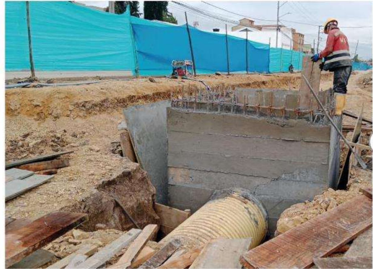
Constructora Bolívar Construcción de la red Pluvial
